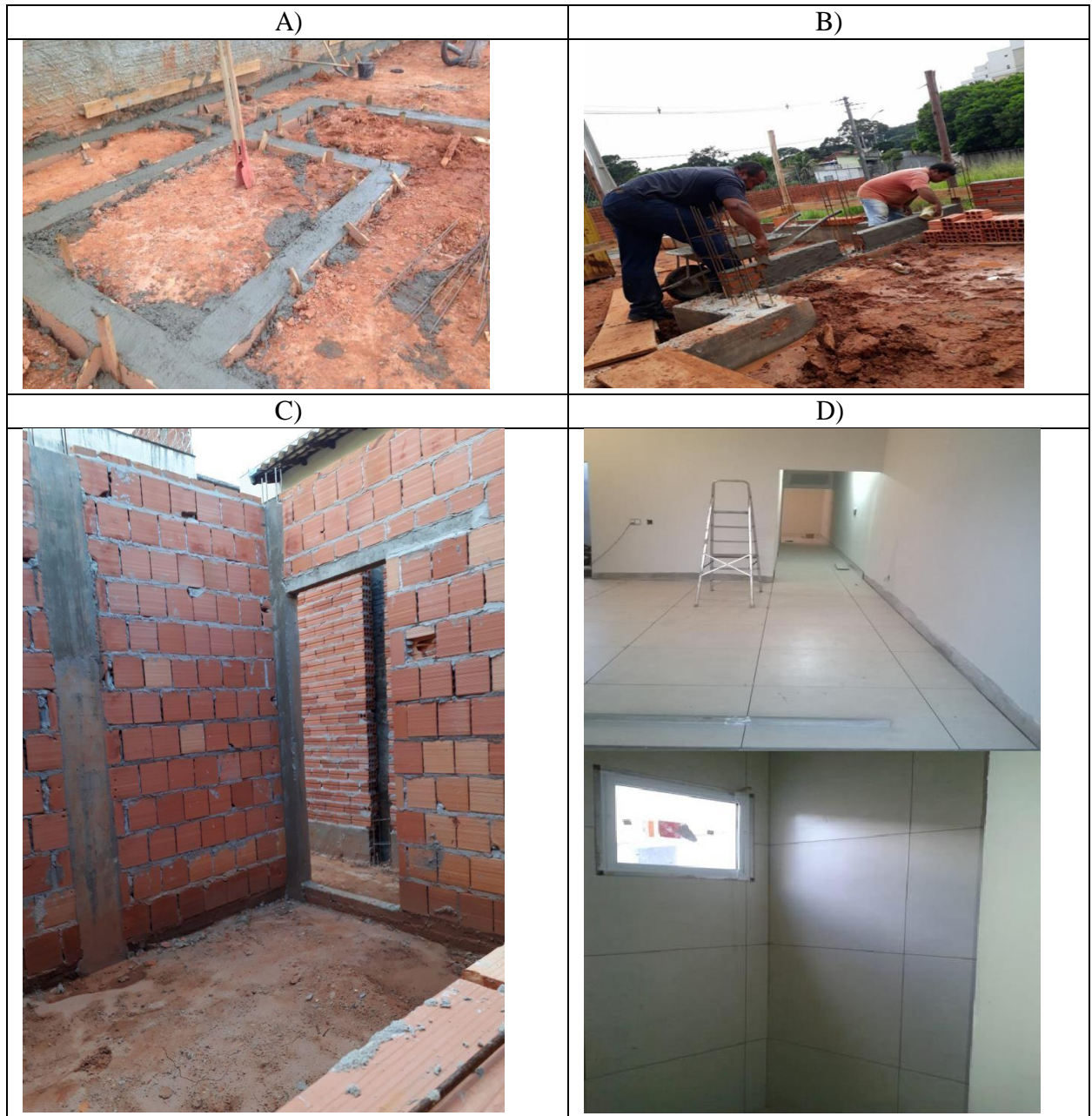
Figura 1 – A) Baldrame, B) Alvenaria de embasamento, C) Alvenaria de fechamento D) Assentamento dos revestimentos cerâmicos.
