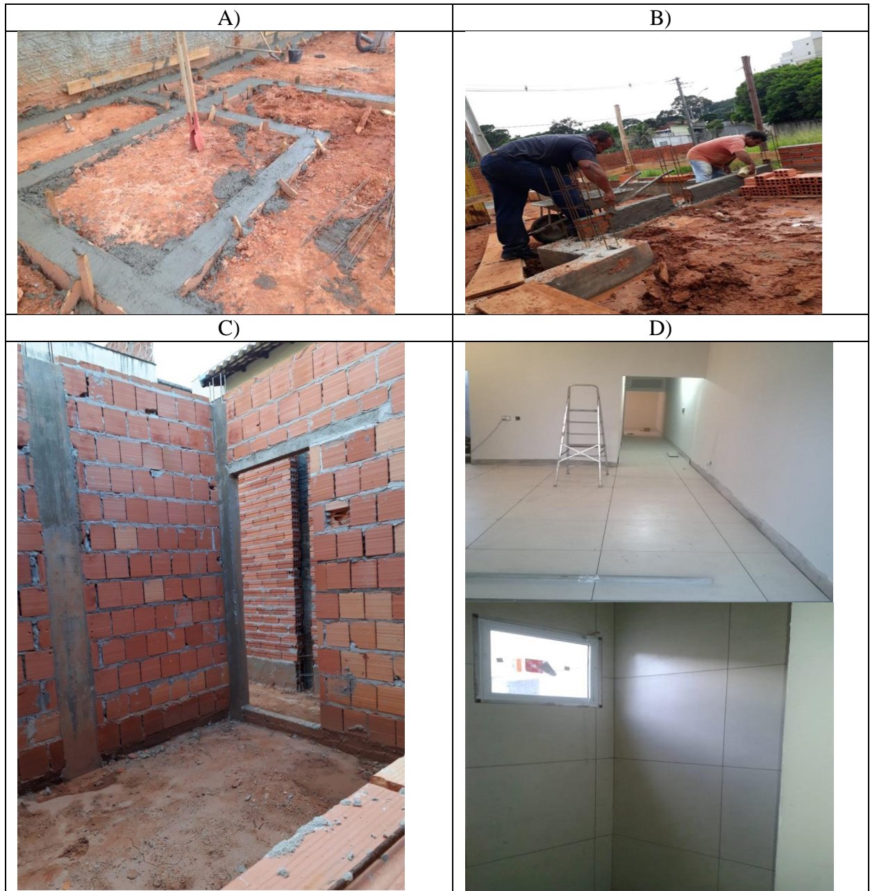
Figura 1 – A) Baldrame, B) Alvenaria de embasamento, C) Alvenaria de fechamento D) Assentamento dos revestimentos cerâmicos.
