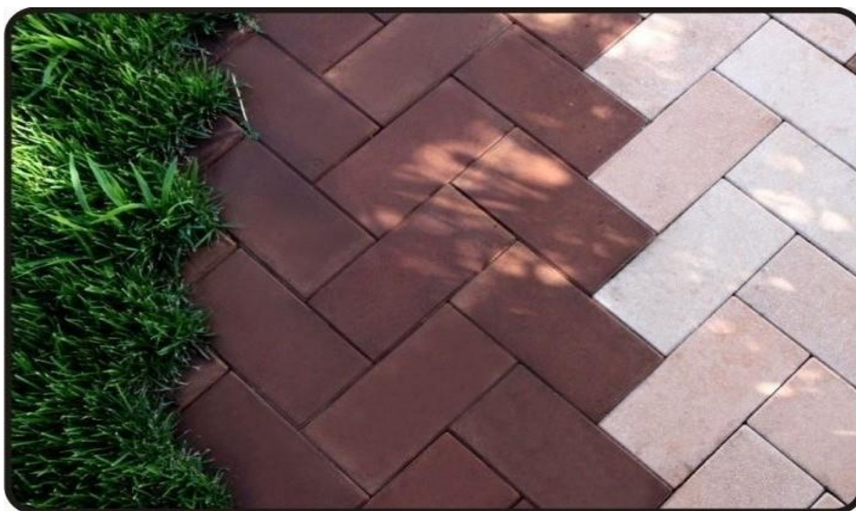
Figura 1 – Piso Ecológico Área Externa
