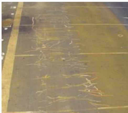
Figura 4- Asfalto convencional em 98000 ciclos
