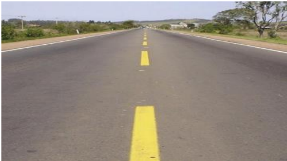
Figura 2- Trecho experimental – BR116/RS – 3anos –Asfalto borracha
