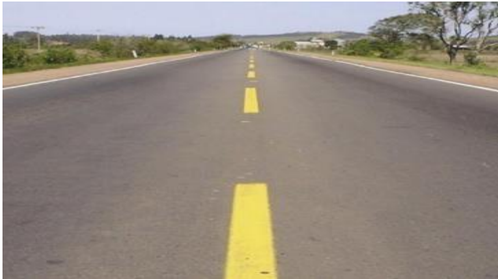
Figura 2- Trecho experimental – BR116/RS – 3anos –Asfalto borracha
