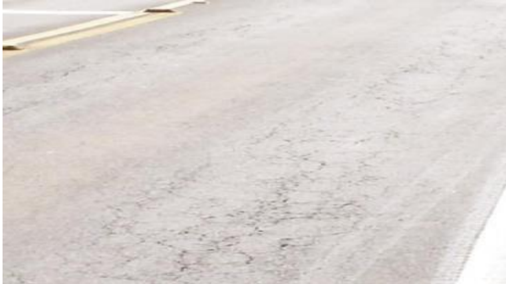
Figura 1- Trecho experimental – BR116/RS – 3anos –Asfalto convencional
