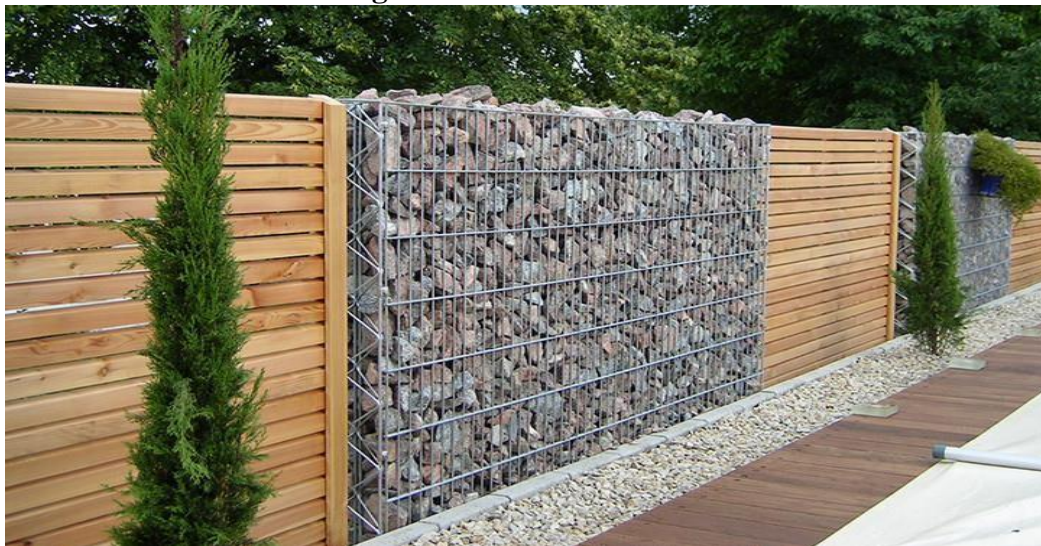
Figura. 2– Muro de Gabião
