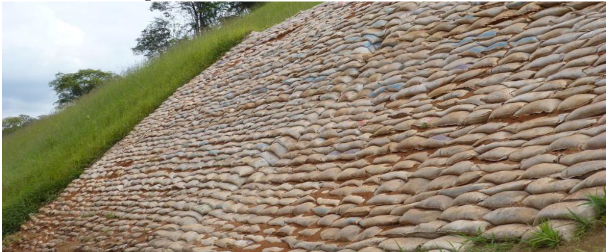
Figura. 5 - Muro de sacos de solo-cimento ensacados
