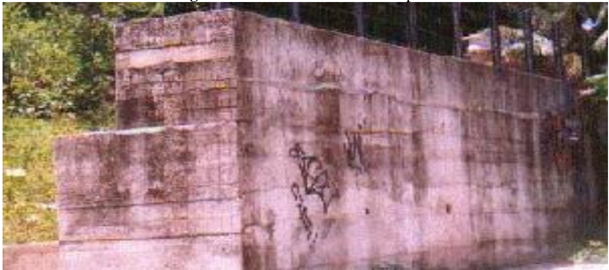
Figura. 3 – Muro de concreto ciclópico
