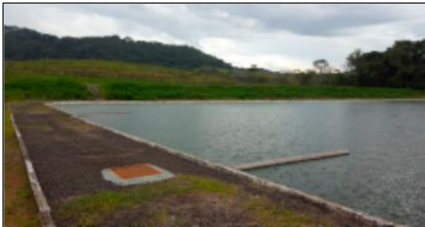
Figura 5 - Vista da lagoa de maturação da ETE de Oriente/SP
