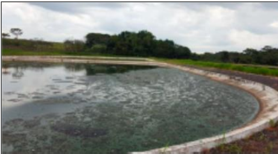
Figura 3 - Vista da lagoa anaeróbia da ETE de Oriente/SP
