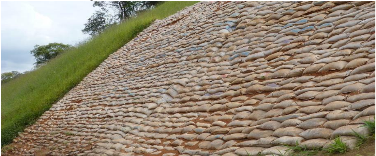
Figura. 5 - Muro de sacos de solo-cimento ensacados
