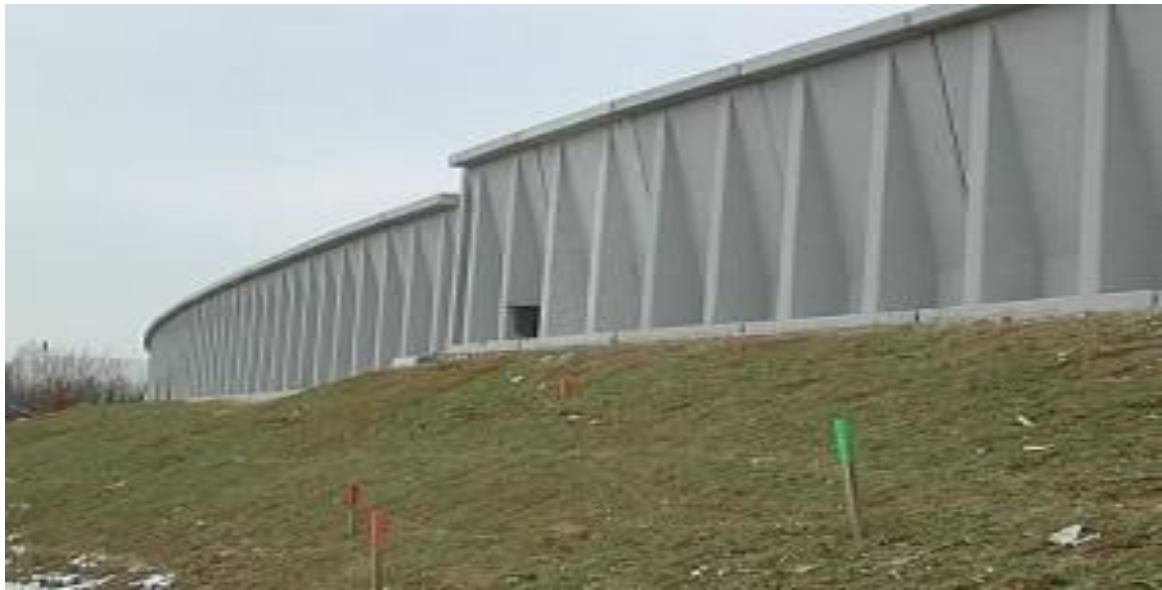
Figura. 7 - Muro de concreto armado
